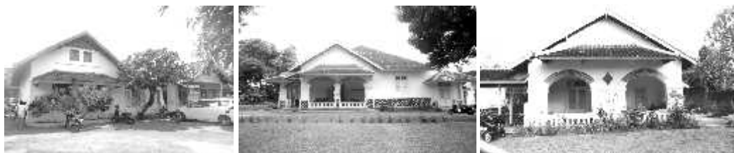
Gambar 11. Tipologi fasade bangunan kolonial berdasarkan periode pembangunan tahun 1902-1920
