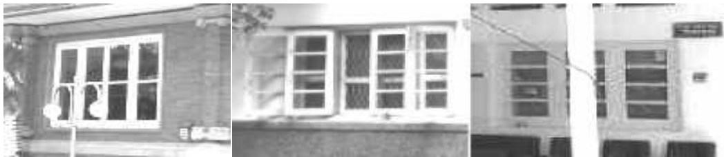
Gambar 10. Tipologi fasade bangunan kolonial berdasarkan jendela rangkap ganda kaca
