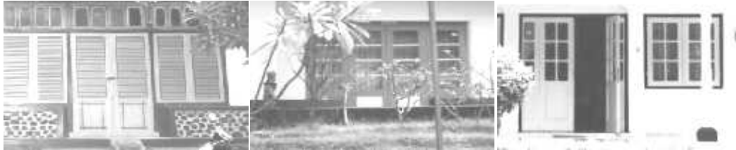
Gambar 9. Tipologi fasade bangunan kolonial berdasarkan pintu ganda kreyak (kiri) dan pintu ganda kaca (tengah dan kanan).
