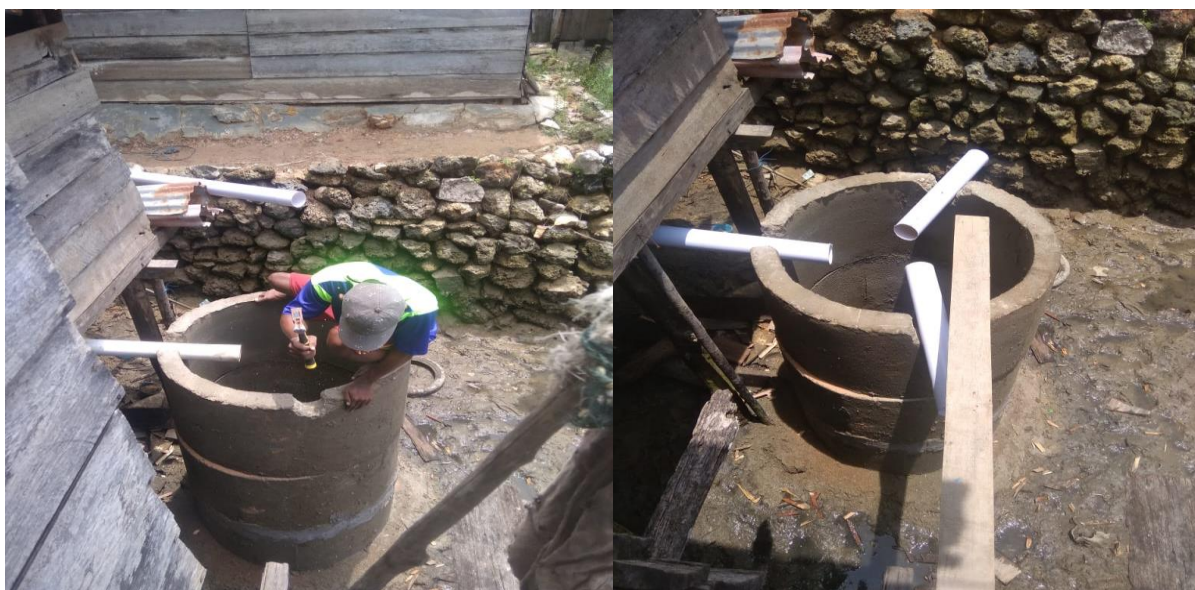
Gambar 2. Pembuatan Septic Tank Komunal
