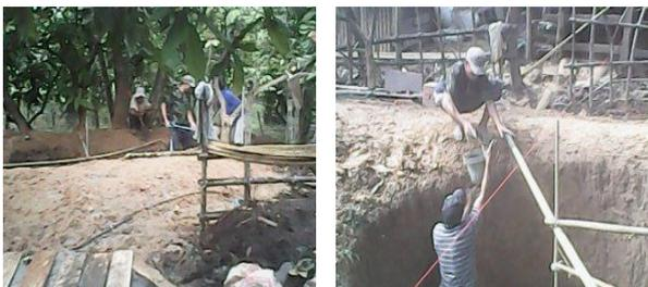
Gambar 3a. Pengalians Bak, 3b. Proses Pengecoran Lantai bak
