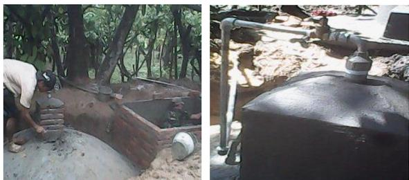
Gambar 4a. Pemasangan Jaringan Pipa dan KGU, 4b. Pembuatan Menara Pipa Gas
