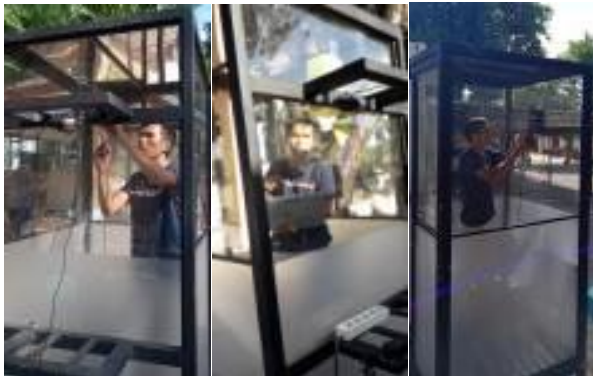
Gambar 8. Proses Pemasangan Kontrol Otomatis
