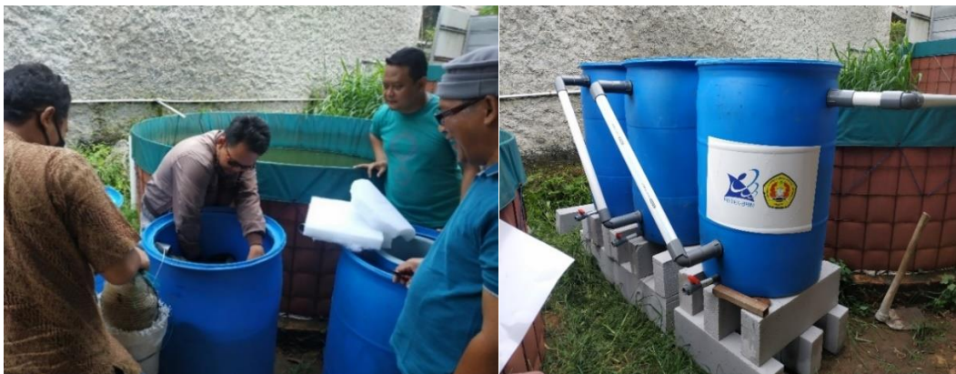
Gambar 5. Kegiatan pemasangan filtrasi air kolam budidaya ikan
