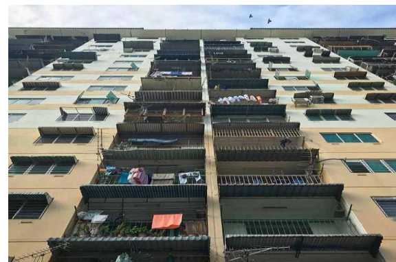
Gambar 1. Kondisi Rumah Susun Di Indonesia saat ini
