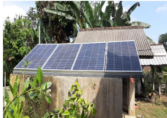
Gambar 3. Pemasangan Panel Surya
