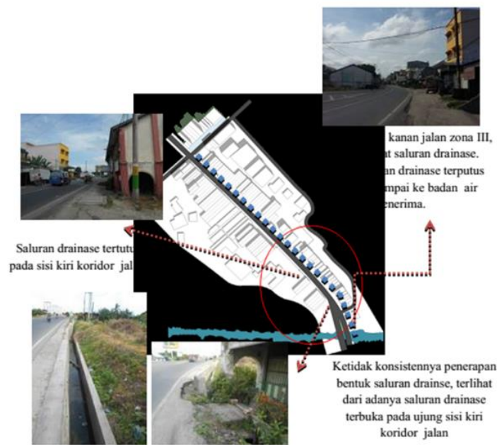
Gambar 3. Saluran drainase Segmen 1 Koridor Sei Rampah
