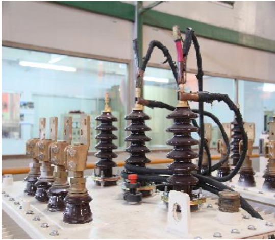
Gambar 10. Pemasangan kabel probe terhadap bushing untuk pengujian tegangan tinggi (H1) dengan (H2) pada software.
