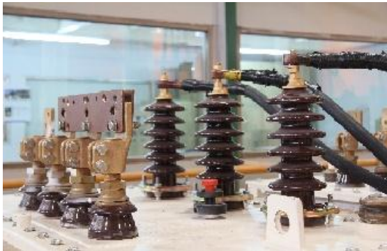
Gambar 11. Pemasangan kabel probe terhadap bushing untuk contoh pengujian tegangan tinggi (H1-H2-H3 dengan x1-x2-x3 dihubung singkat) pada software.
