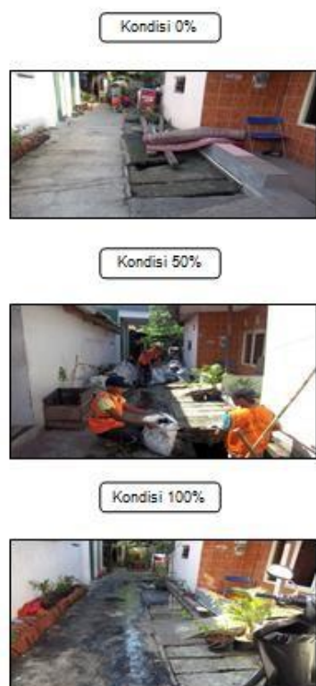
Gambar 3. Pengecekan dan Pengurusan Saluran
