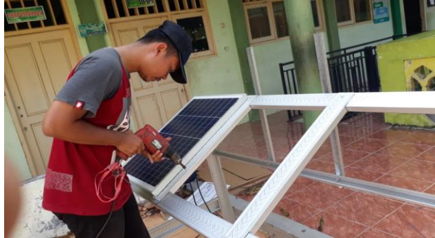
Gambar 11. Pemasangan PV
