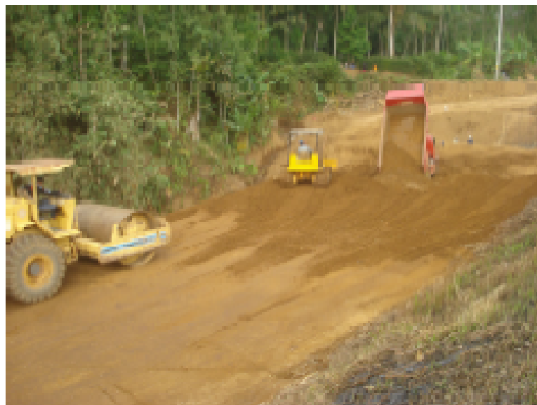
Gambar 2. Pekerjaan pemadatan
