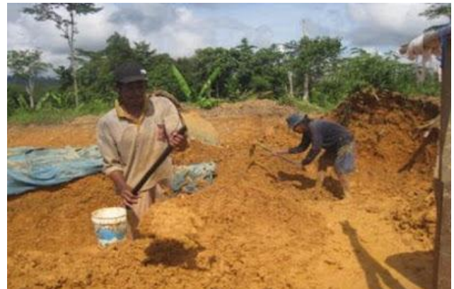
Gambar 4. Penggilasan tanah dengan cangkul
