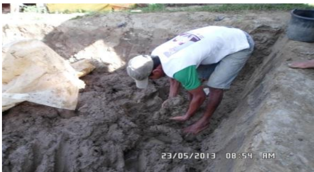
Gambar 6. Tanah siap untuk dicetak bata merah
