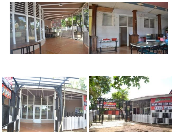
Gambar 8. Foto Keadaan Eksisting Eksterior Kantin.
