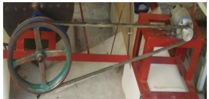
Gambar 6. Penempatan Generator Untuk PLTMH
