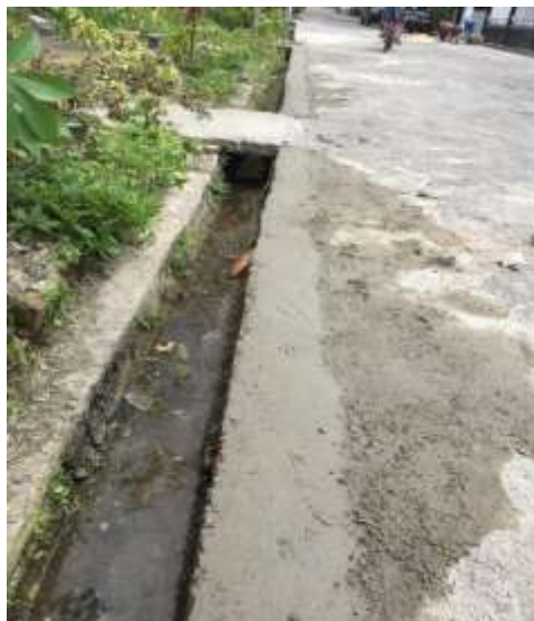
Gambar 1. Kondisi Jalan Setelah Pelebaran
