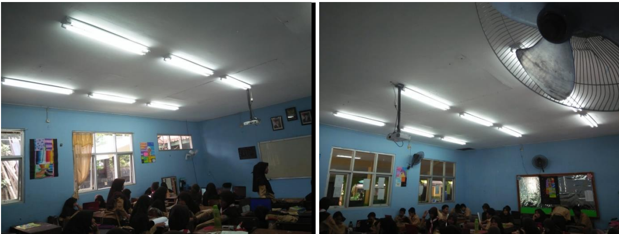
Gambar 5. Ruang kelas SMP N 2 Cibinong setelah retrofit lampu
