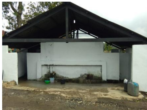
Gambar 6. Bangunan MCK selesai Renovasi
