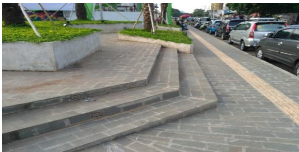
Gambar 2. Kondisi Jalur Pedestrian di Sekitar Taman Gajah
