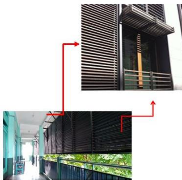
Gambar 19. Solusi penerapan folding shutter pada area koridor lantai 2 dan 3.
