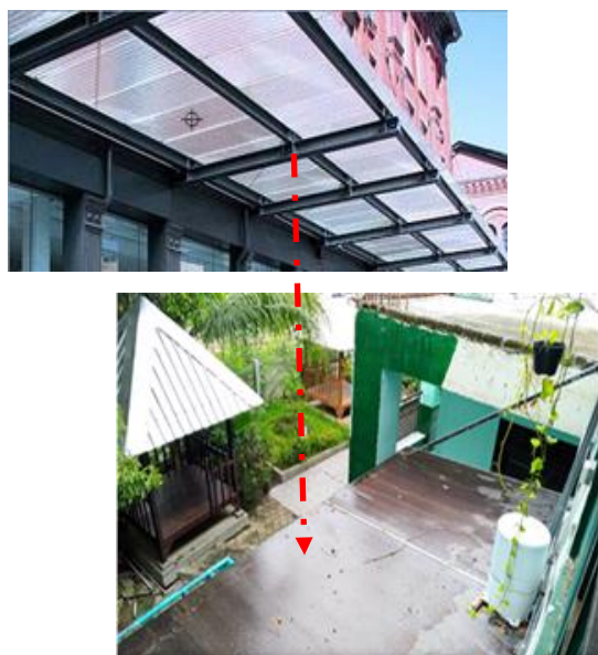
Gambar 14. Penerapan overhang transparan pada bagian timur kelas.
