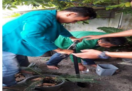
Gambar 3. Praktik pembuatan lubang resapan biopori
