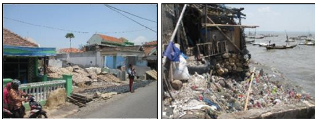
Gambar 2. Kondisi Fisik Bangunan dan Pengelolaan Persampahan di RW 2 Kelurahan Kedung Cowek
