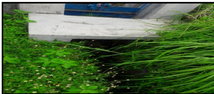
Bangunan bagi dentim
