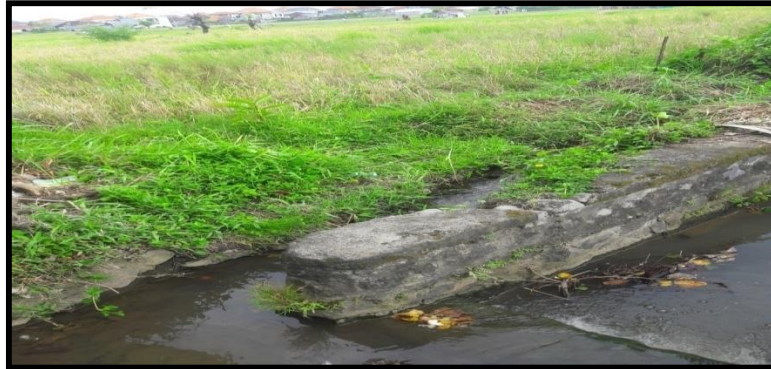
Bangunan sadap dentim
