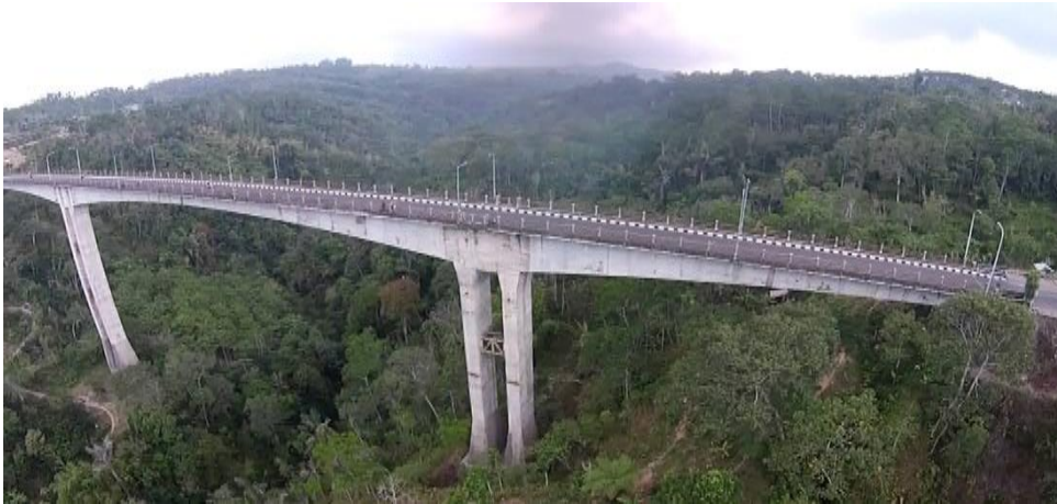
Gambar 3.3 Existing Jembatan Tukad Bangkung
