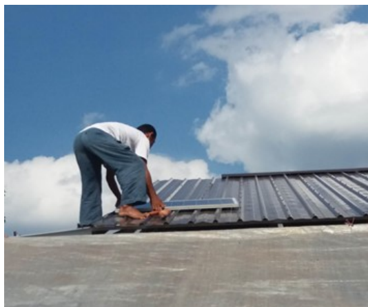
Gambar 5 Pemasangan Panel Surya
