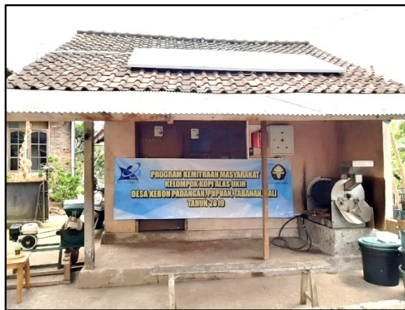
Gambar 13. Pemasangan PLTS dan instalasi listriknya telah selesai
