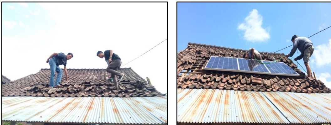
Gambar 11. Pemasangan modul surya
