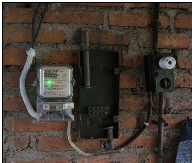
Gambar 3. Meteran PLN dan instalasinya
