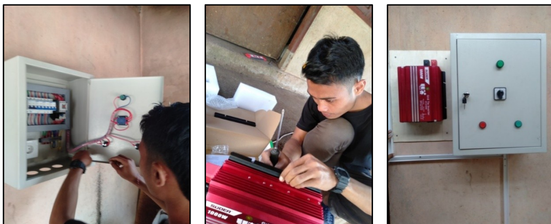
Gambar 12. Pemasangan inverter
