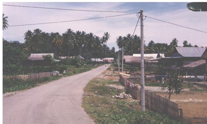
Gambar 5. Jaringan Tegangan Rendah
