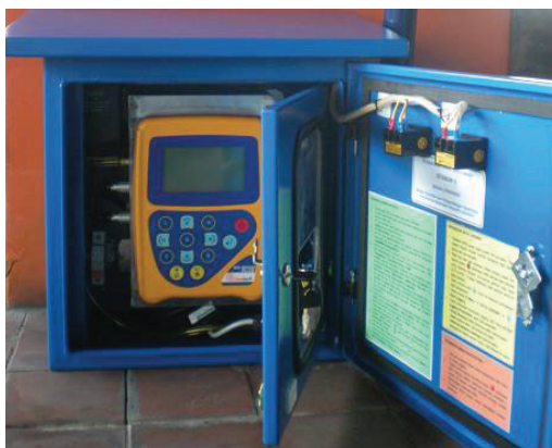
Gambar 14. Bentuk panel kontrol yang sudah selesai dirakit
