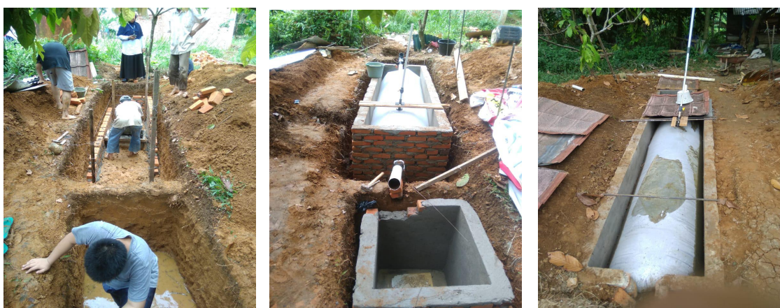
Gambar 4. Pemasangan Instalasi Biogas
