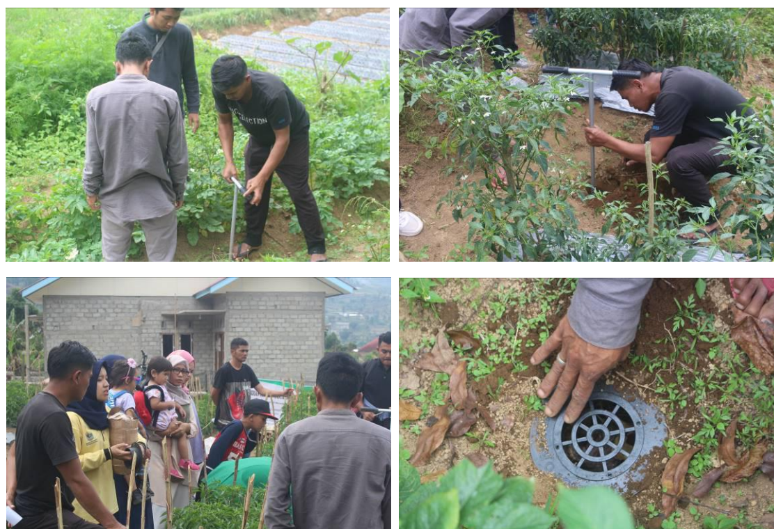
Gambar 6. a) Teknik Pembuatan LRB, b) Mengukur Kedalaman LRB, c) Anggota Kelompok Tani Memperhatikan Demonstrasi Aplikasi LRB di lahan, d) setelah Selesai, LRB ditutup.
