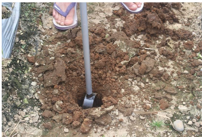
Gambar 3. Proses Pemboran Lubang Resapan Biopori
