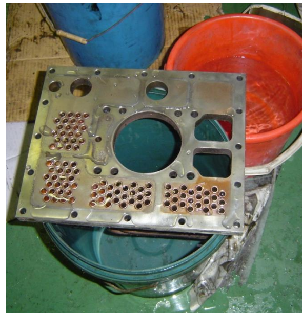
Foto 3. Dinding-dinding intercooler yang sudah dibersihkan
