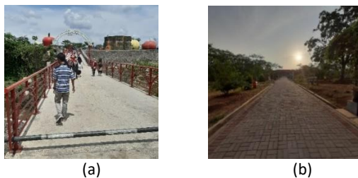
Gambar 2 Fasilitas Pejalan kaki: (a) Jembatan, (b) Pedestrian. (Sumber: Dokumentasi Penulis,2019)
