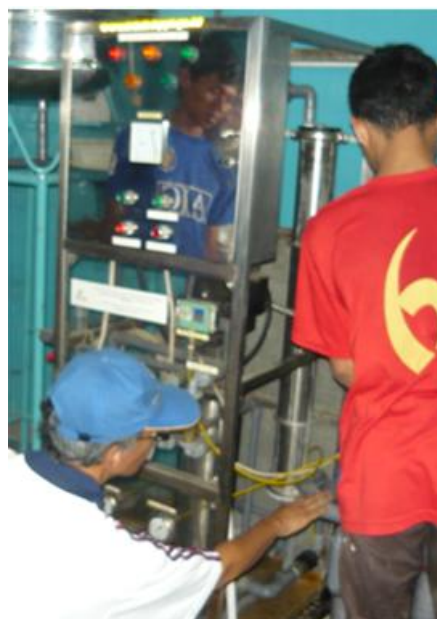
Gambar 7. Unit Membran RO yang sedang di Pasang.
