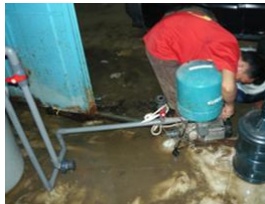
Gambar 2. Perbaikan Pompa Air Baku.
