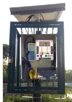
Gambar 9 : Perakitan Boks Panel Dan Panel Surya.
