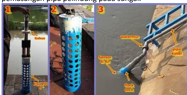
Gambar 10 : Perakitan Dan Pemasangan Pelindung Sensor.
