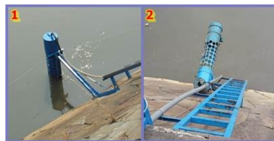
Gambar 13 : Hasil Pemasangan Struktur Pelampung.
