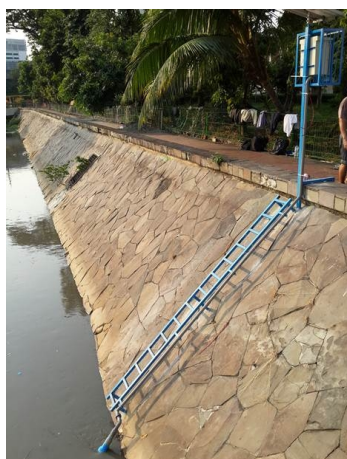
Gambar 11 : Hasil Pemasangan Akhir Bangunan Online Monitoring.
