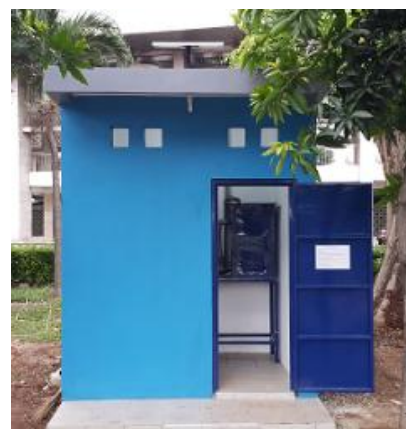
Gambar 6: Bangunan Pelindung Sistem Online Monitoring Di Sungai Ciliwung Segmen Masjid Istiqlal.
