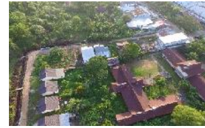
Gambar 5.3. Kondisi Jalan Lingkar Luar yang Membutuhkan Pagar Pengaman
