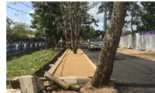
Gambar 5.5. Trotoar di Jalan Lingkar Dalam Bagian Samping
