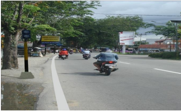
Gambar 10. Kondisi penanganan jalan Adi Sucipto Sta 3 – 4
