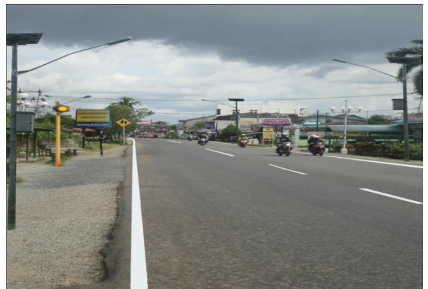
Gambar 12. Kondisi penanganan Sta 6 – 17 jalan Adi Sucipto.
