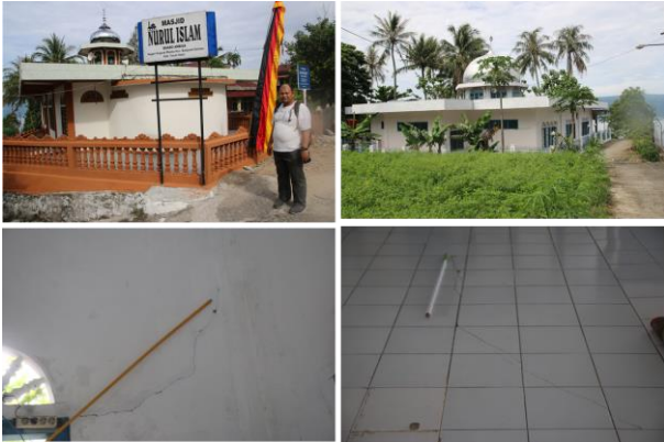
Gambar 1. Kondisi kerusakan bangunan mesjid Nurul Islam
