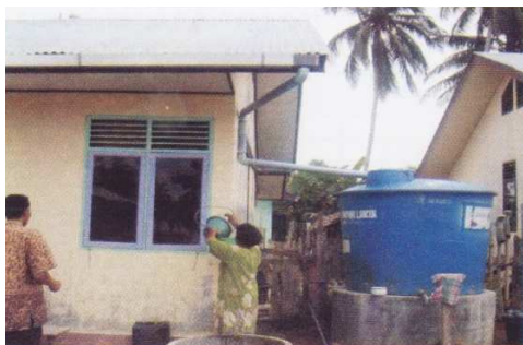
Gambar 4. Tandon penampung air hujan untuk memenuhi kebutuhan air (Sumber: Maryono dan Nugroho, 2006)
