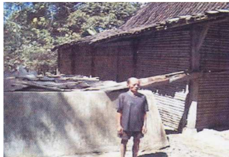
Gambar 4. Tandon penampung air hujan untuk memenuhi kebutuhan air (Sumber: Maryono dan Nugroho, 2006)
