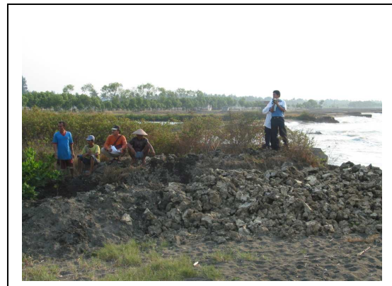
Foto 7. Kondisi Pematang Tambak Pantai Maribaya, Kabupaten Tegal Yang Habis Tertelan Gelombang.
