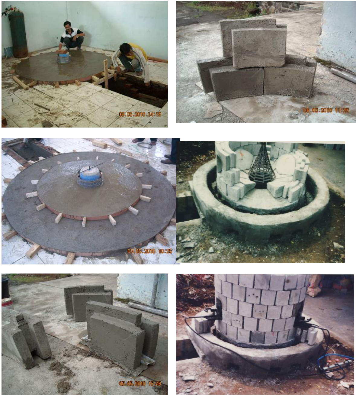
Gambar 9. Foto proses pembuatan tungku dan pengetesan dinding primer
