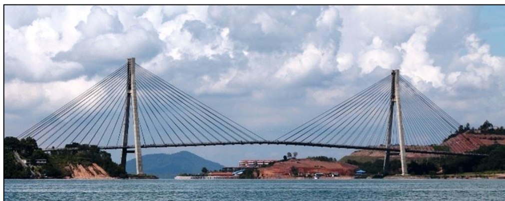
Gambar 3. Tampak samping jembatan I Barelang
