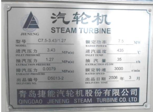
Gambar 6. Spesifikasi teknis turbin uap di PLTBm PT. Harjohn Timber [2][8]
