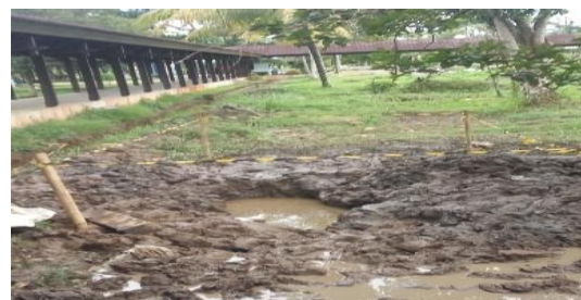
Gambar 3 Proses pencampuran tanah dengan bahan additive
