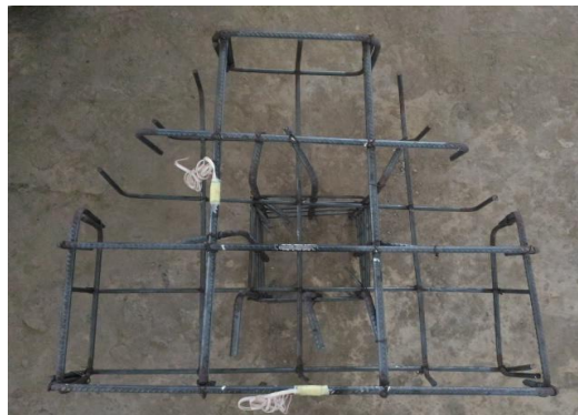
Gambar 5. Perakitan Baja Tulangan Metode Konvensional
