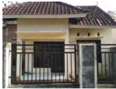
Gambar 4. Kondisi Rumah Graha Satelit
