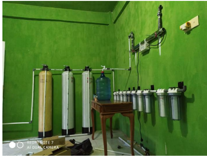
Gambar 8. Instalasi telah Terpasang
