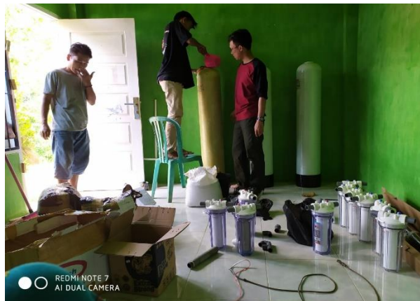
Gambar 6. Proses Pemasangan Instalasi Pengolahan Air Bersih Dan Pengisian Tabung Media
