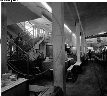
Gambar 2. Letak dan kondisi tangga menuju lantai 2
