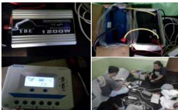
Gambar 3. Material dan Pengujian PLTS
