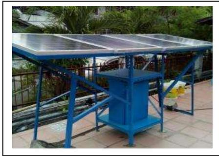
Gambar 5. Kerangka Tempat Penempatan Panel Surya dan Peralatan
